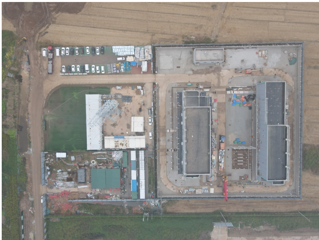
施工现场照片
