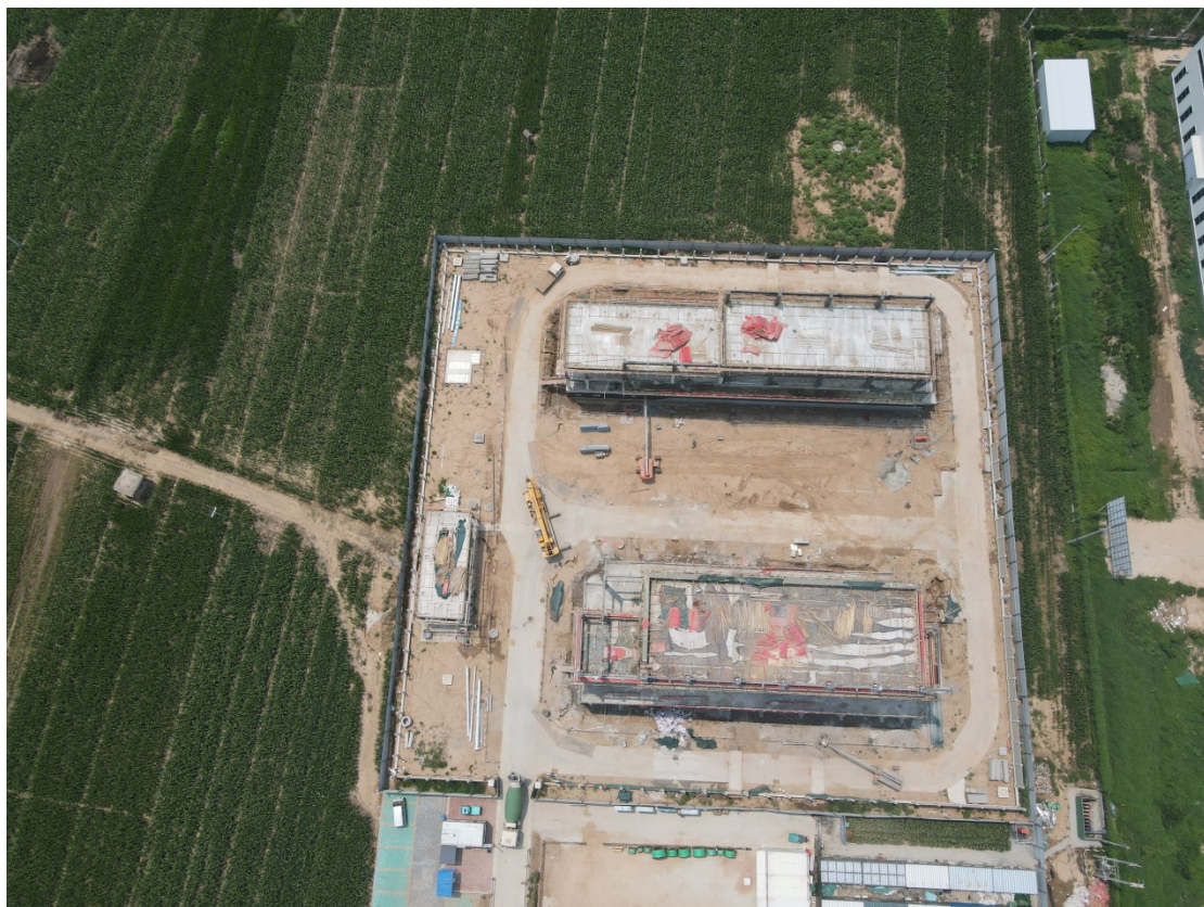
施工现场照片
