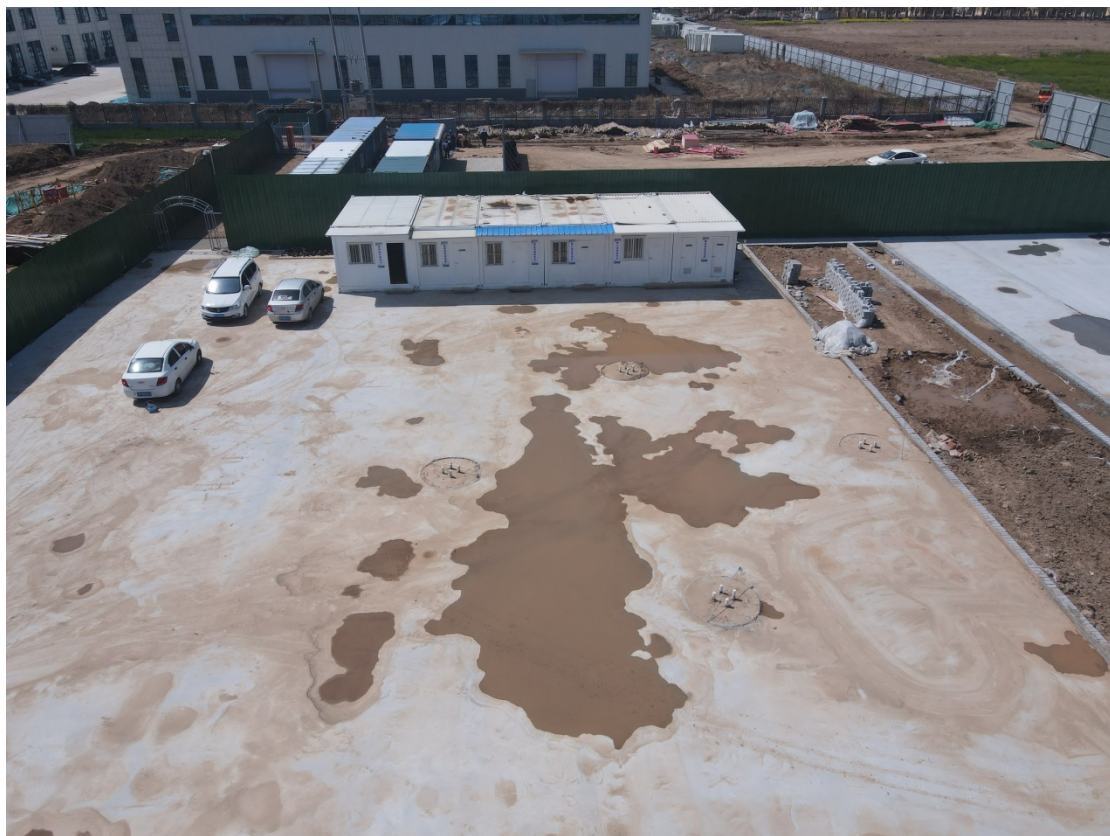
施工现场照片
